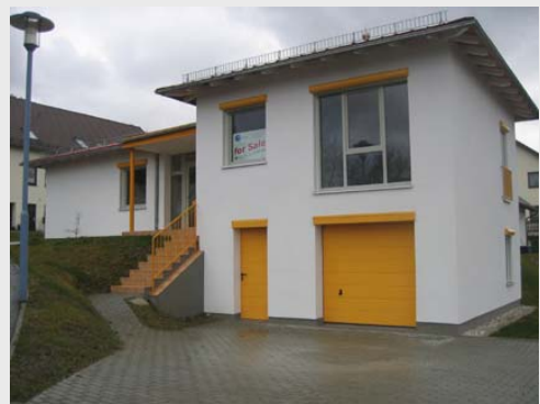
Einfamilienhaus Plauen (Baujahr 2006)
